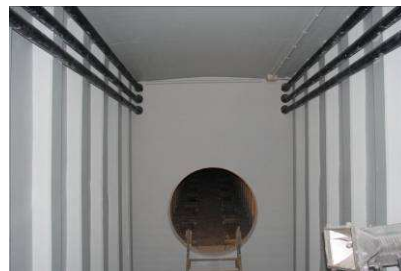
Figura 3. Maciços desviadores para o pré-esforço exterior
