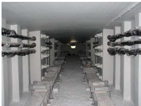
Figura 4. Vista do reforço pelo interior dos tramos em caixão
