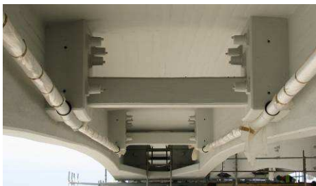
Figura 2. Pré-esforço exterior nos tramos correntes
