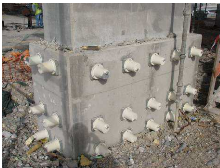
Figura 5. Reforço da base dos fustes dos pilares
