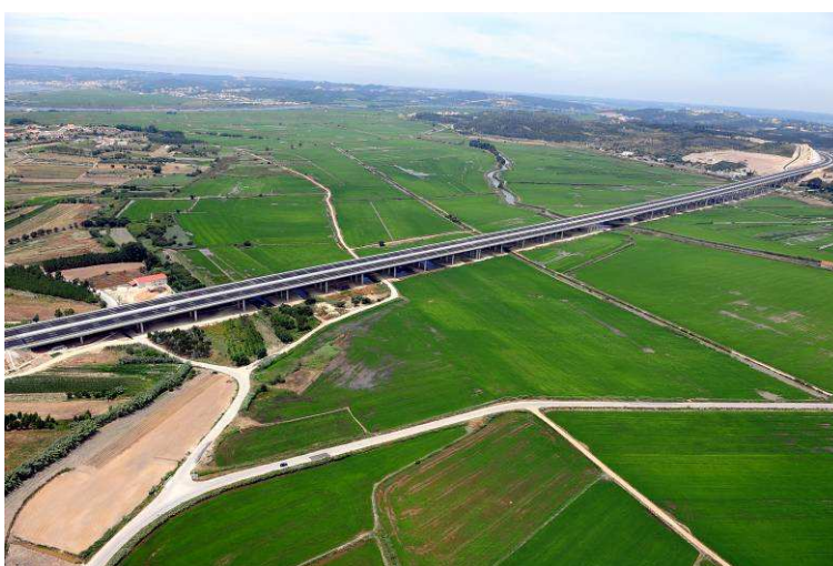
Figura 2. Ponte sobre o Rio Pranto e Viadutos de Acesso
