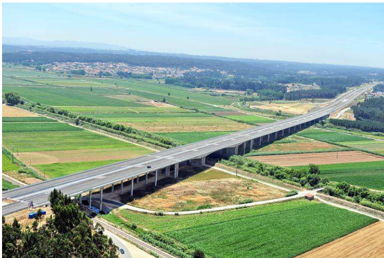
Figura 1. Ponte sobre o Rio Lis e Viadutos de Acesso
