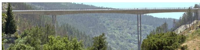
Figura 1: Ponte de Fagilde sobre o rio Dão
