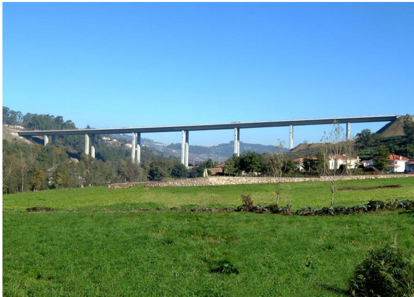
Figura 2: Viaduto sobre o rio Vizela
