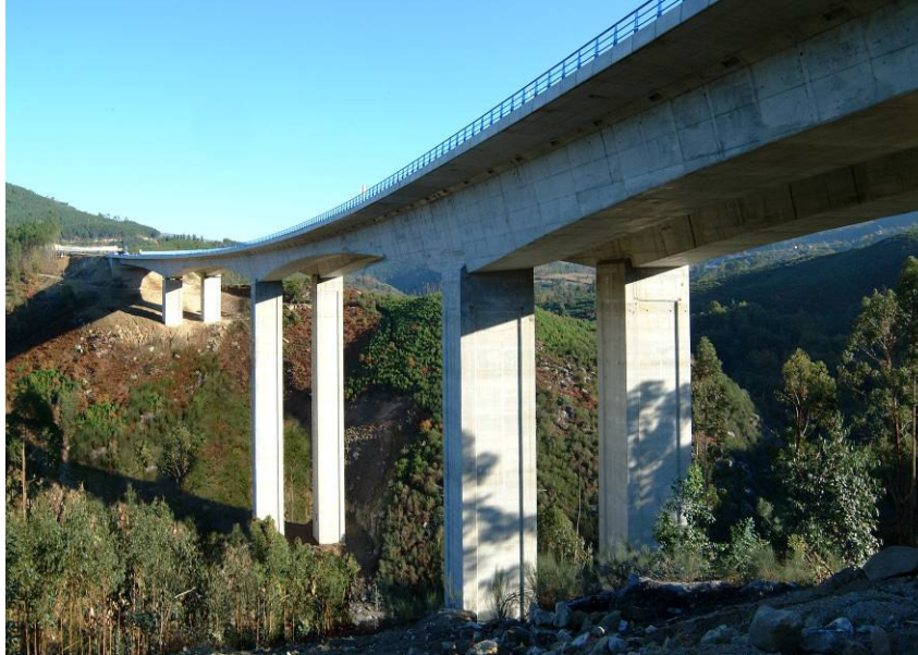
Figura 1: Ponte sobre o rio Louredo
