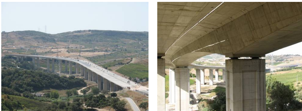
Figura 1: Vistas gerais da obra no final da construção
